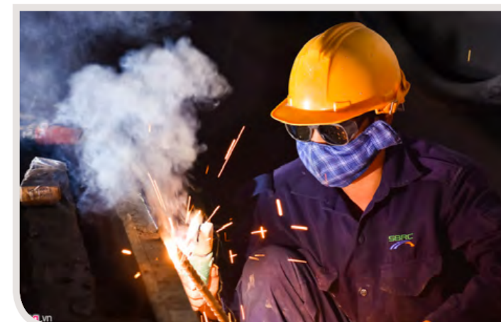
▲ Công nhân hàn xì thi công hệ thống thoát nước trong hầm
