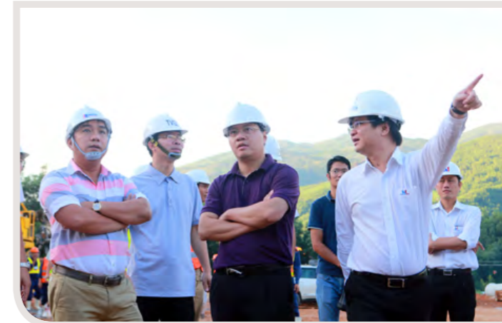
▲ Chủ tịch HĐQT Hồ Minh Hoàng cùng Ban Lãnh đạo Tập đoàn Đèo Cả thăm và kiểm tra công trường hầm Cù Mông
