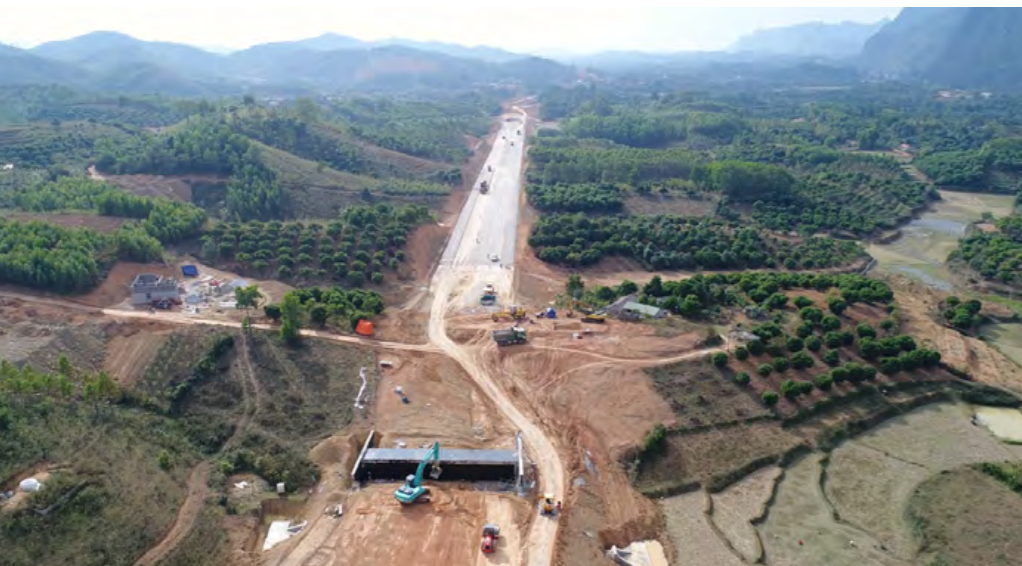
▲ CAO TỐC HỮU NGHỊ - CHI LĂNG ĐANG THI CÔNG
