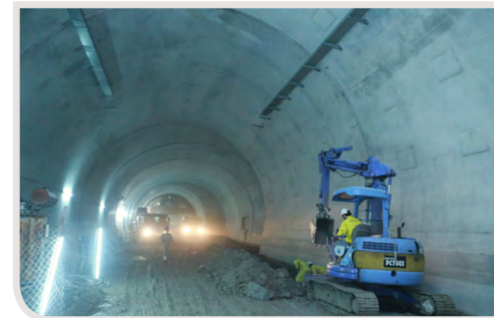
▲ Nhịp điệu công trình giai đoạn cuối
