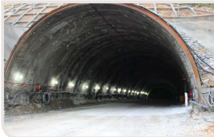
▲ Hoàn thành 100m hầm Cù Mông đầu tiên
