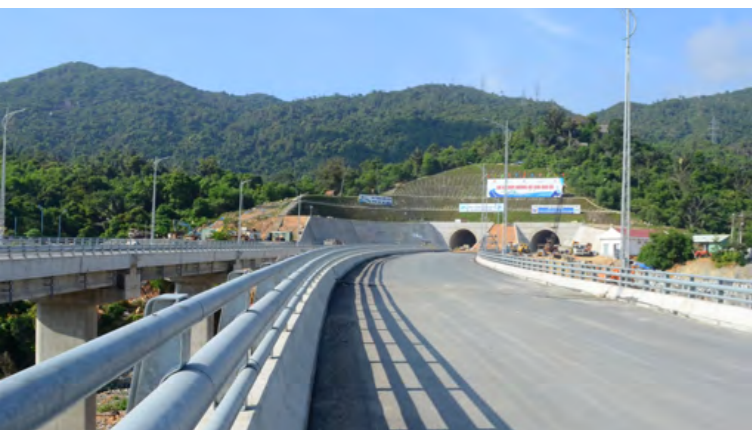
▲ HẦM ĐƯỜNG BỘ ĐÈO CẢ
