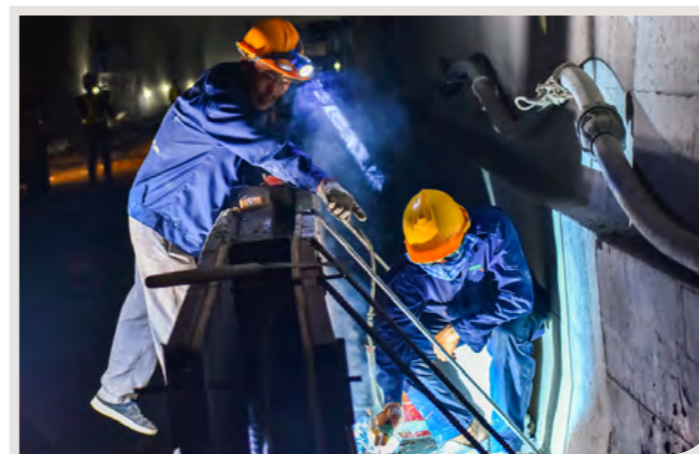
▲ Bên trong công trình dài hun hút, nhiều nhóm công nhân chia làm các mũi lắp đặt lớp phòng nước đi trước, 5 mũi đổ bê tông vỏ hầm cần mẫn làm việc
