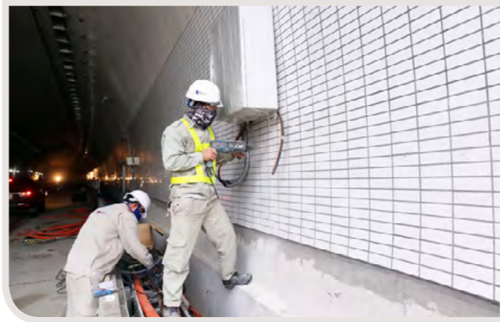
▲ Lắp đặt các hệ thống thuộc phần cơ điện trong hầm
