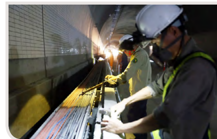
▲ Các nhà thầu đang tập trung bố trí 20 mũi thi công, với hàng trăm cán bộ, kỹ sư, công nhân
