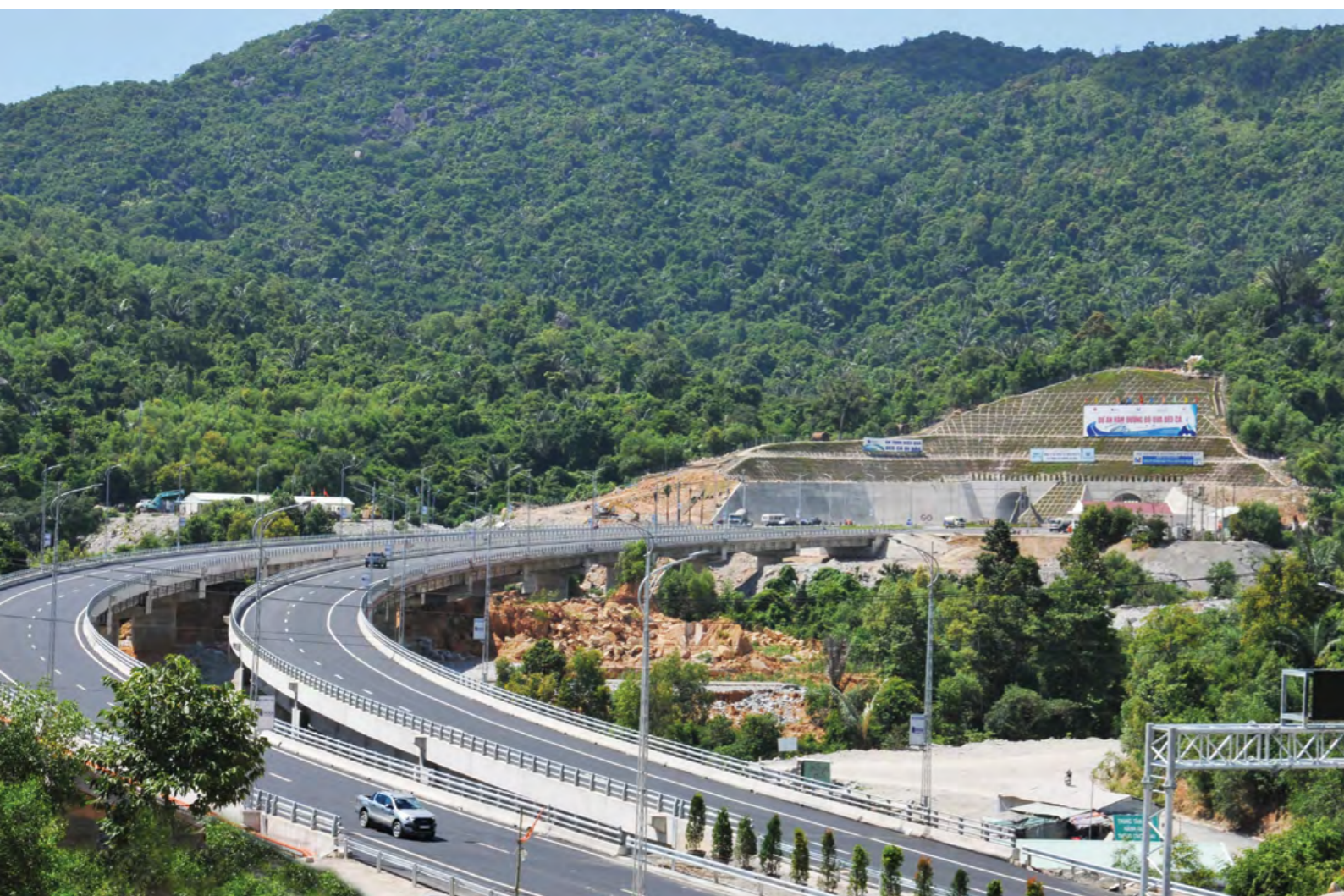
▲ ĐƯỜNG DẪN VÀO HẦM ĐÈO CẢ
