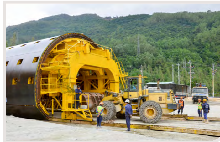
▲ Những công đoạn cuối cùng để đưa công trình hầm Cù Mông về đích
