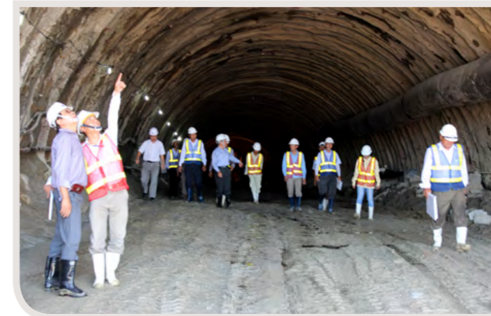
▲ Hội đồng nghiệm thu Nhà nước kiểm tra định kỳ về chất lượng công trình dự án
