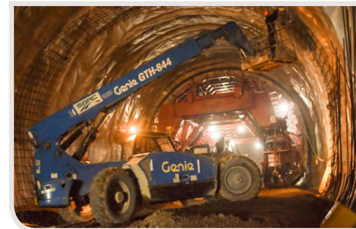
▲ Công trình gồm 2 ống hầm cách nhau 30m, mỗi ống rộng gần 10m, có 2 làn ô tô, dải an toàn, đường bảo dưỡng
